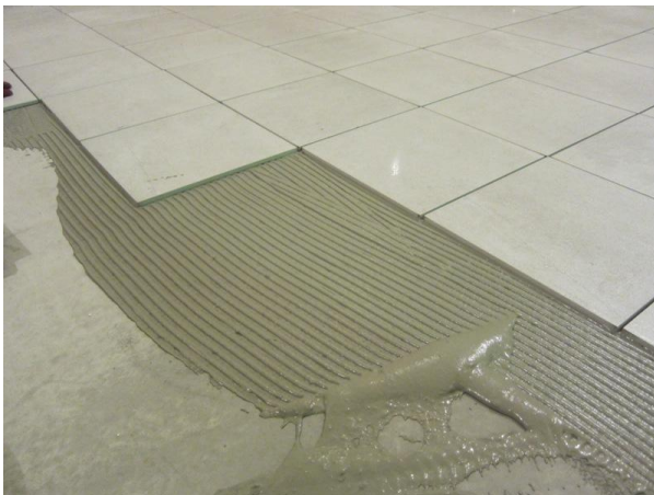
Valokuva 5. Keraamisen laattapäällysteen asennus
