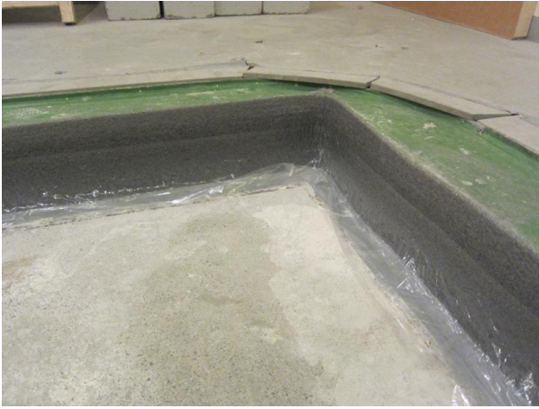
Valokuva 1. Testilaatan suojamuovi ja reunakaista. Valokuva 2. Fescon db-maton asennus
