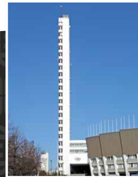
Stenfärg S, Stadion tornet Helsingfors.
